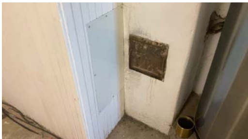
Sotluke i kjeller
