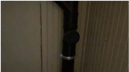
Stakeluke i kjeller
