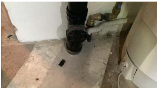
Stakepunkt i kjeller.
