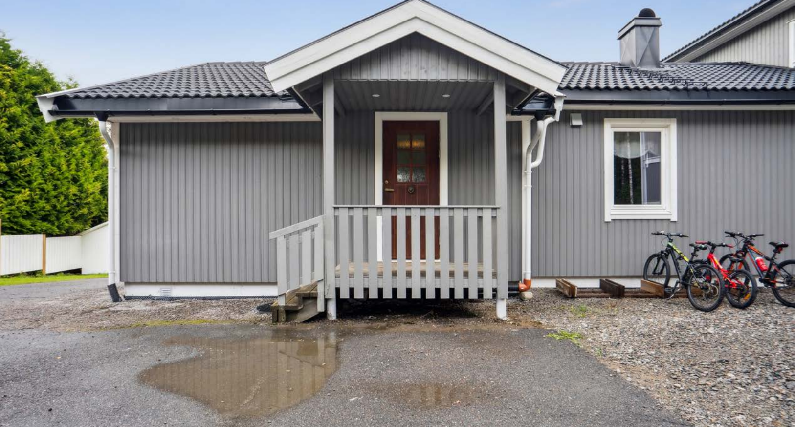
Den opprinnelig eneboligen fra 1966 er renovert (med unntak av kjeller) i 2021.
