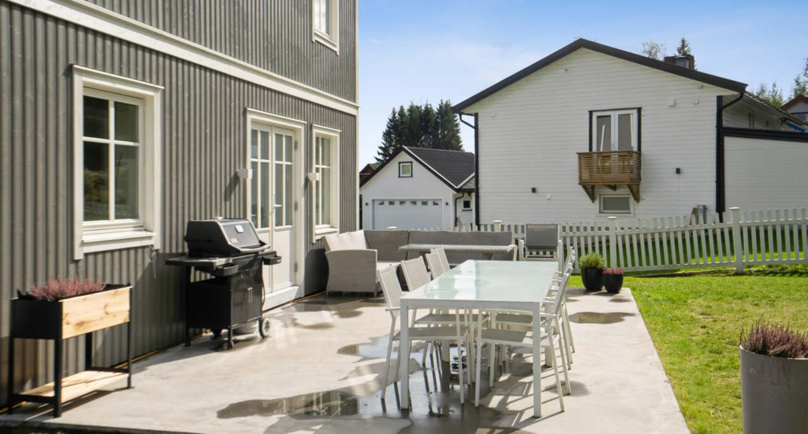
Terrasseplattung av betong.
