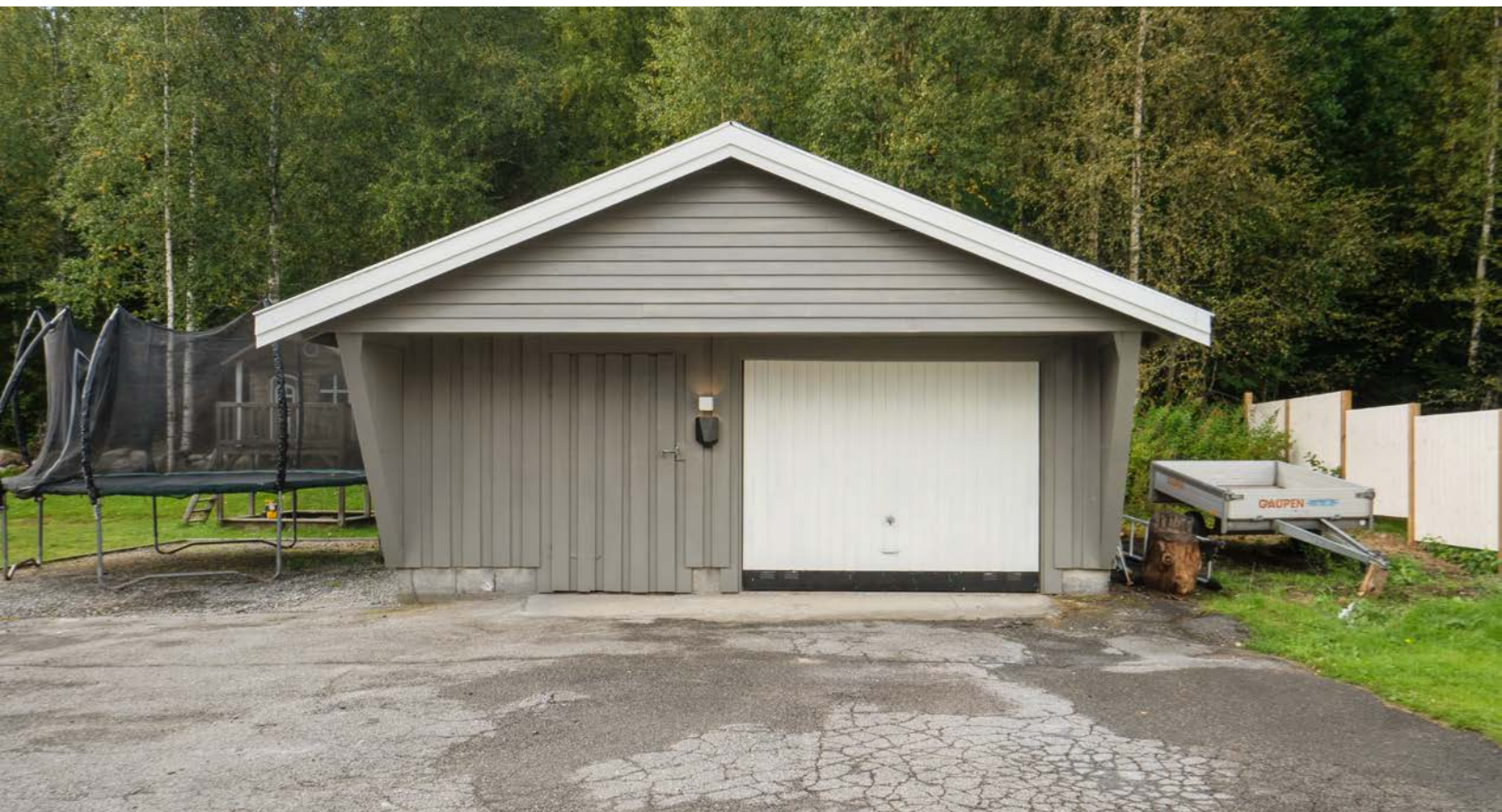
På eiendommen står en eldre garasje m/elbillader.
