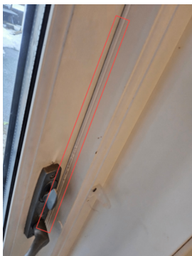
Ødelagt pakning og luftlekkasje på balkongdør ved kjøkken
