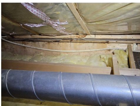
Mangelfull isolering og brudd på dampsperre
