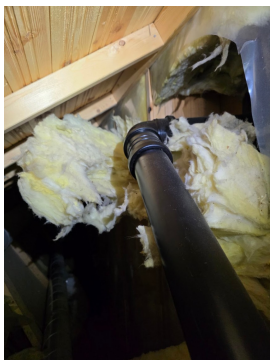
Mangelfull isolering og brudd på dampsperre
