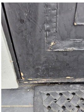
Ødelagt pakning og luftlekkasje på balkongdør ved kjøkken
