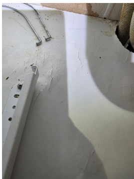
Fuktskader på bunnplate i skrog under vask
