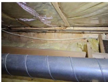
Mangelfull isolering og brudd på dampspærre
