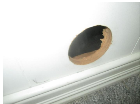
Hulltaking på kontor/arb.rom.
