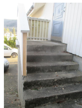
Støpt trapp med nytt rekkverk.
