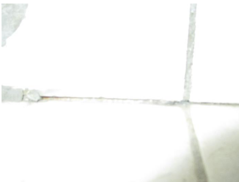
Dårlige fuger og det er bom under flere fliser
