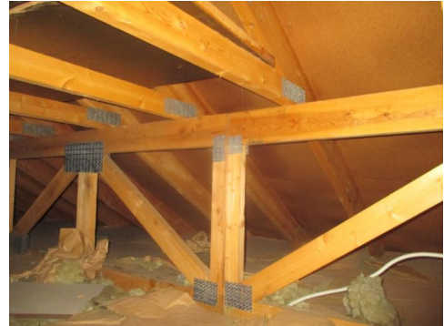
Ferdigproduserte takstoler med sutakplater.
