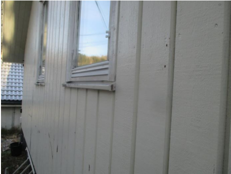
Deler av kledningen med tilhørende belistninger.
