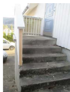
Støpt trapp med nytt rekkverk.
