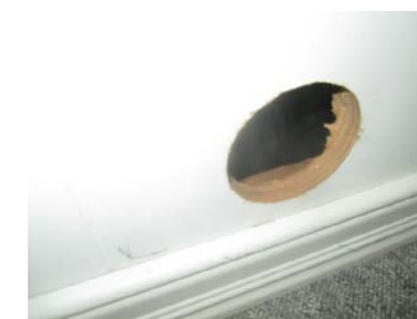
Hulltaking på kontor/arb.rom.
