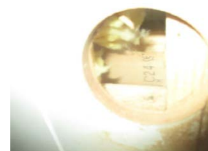
Hulltaking er foretatt i vegg i mot bad.
