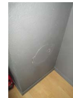
Sotluke nær brennbart materiale.
