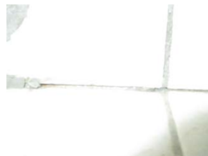
Dårlige fuger og det er bom under flere fliser
