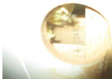
Hulltaking i fra innredning på vaskerommet.
