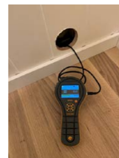
Fuktmåling viste normale verdier.
