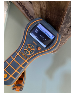
Fuktmåling i takkonstruksjon viste ingen forhøyede fuktverdier.
