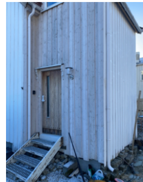
Grunnet kledning på deler av huset
