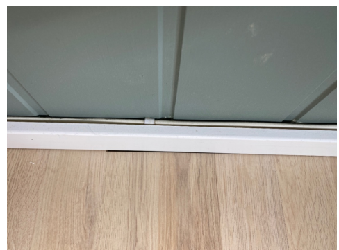
Synlig ende på laminatgulv mot gulvlist.
