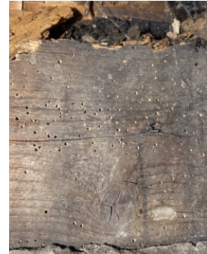
Spor etter borebiller i bjelkelag
