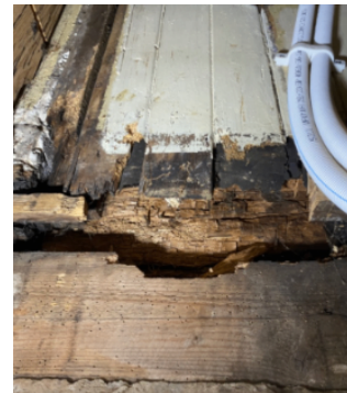
Synlige råteskader sett fra kjeller.
