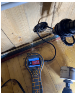
Fuktmåling i innforet vegg mot sørøst.
