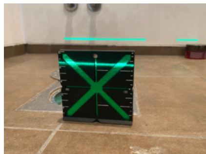
Måling av fall til sluk.
