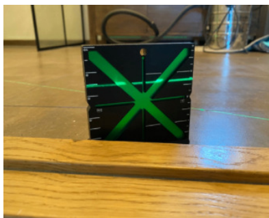
Måling av fall fra dørterskel.
