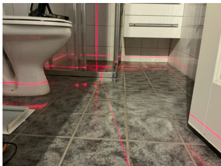
Fall på baderomsgulv er kontrollert med krysslaser.
