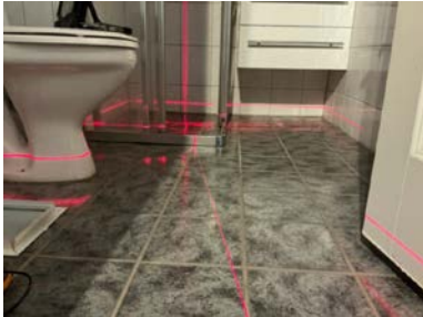
Fall på baderomsgulv er kontrollert med krysslaser.
