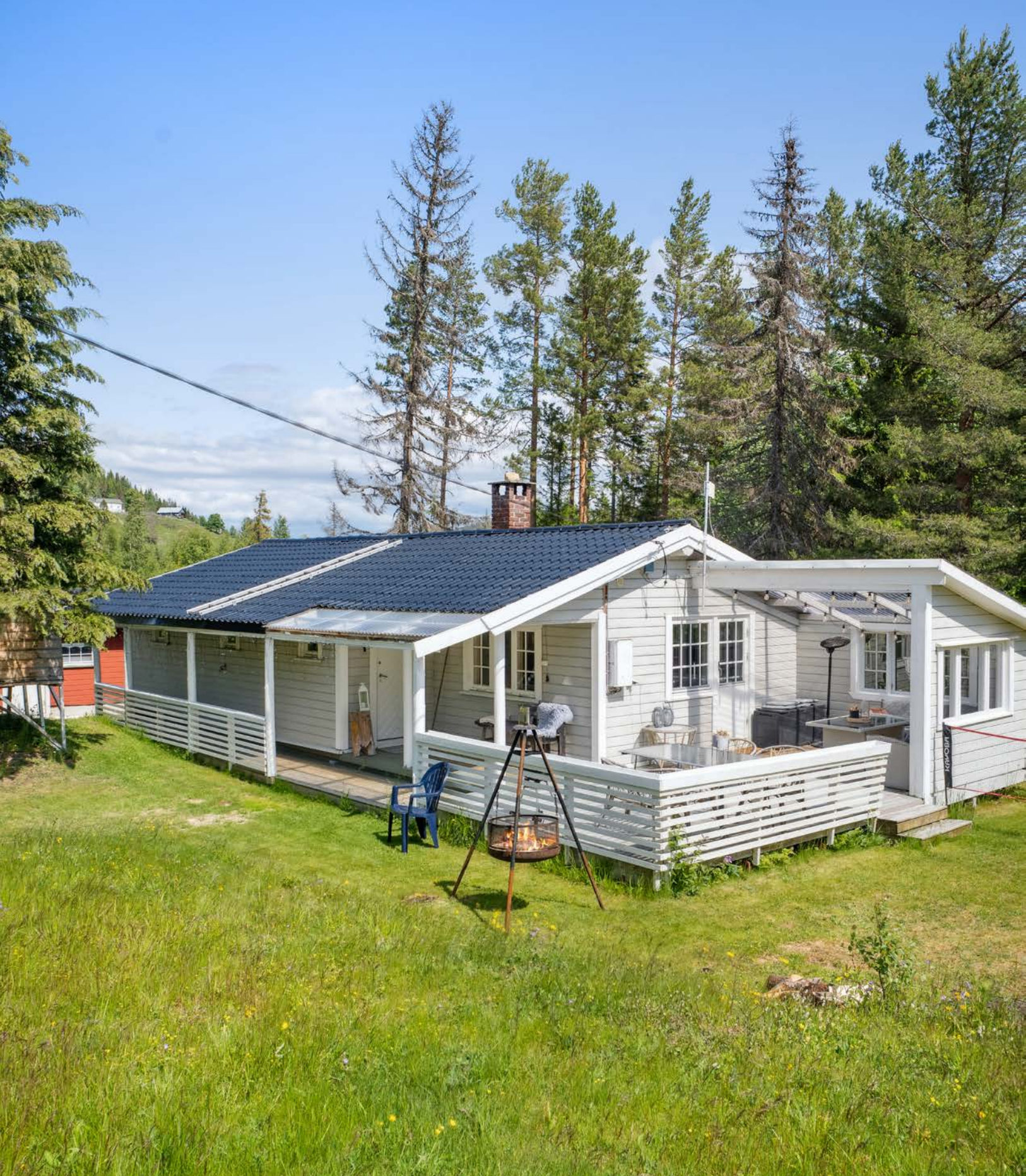
Hytta har overbygget inngangsparti, og en delvis overbygget veranda.
