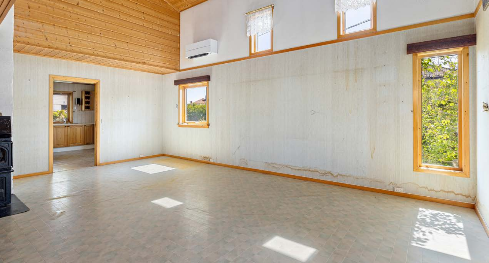
Stuen har moderniseringsbehov
