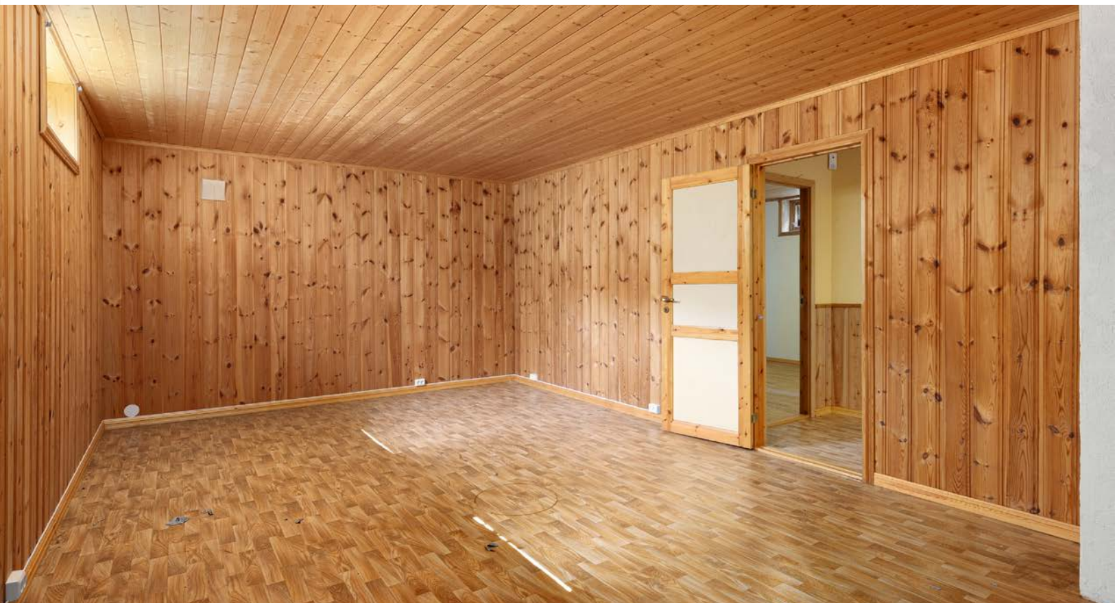
Det er panel på vegger og i himling.
