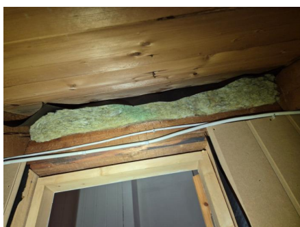
Lite/ingen lufting over innredet loftetasje.
