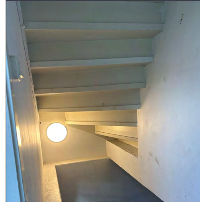
Bilde 4 viser undersiden av trapp fra 1. etasje til 2. etasje.
