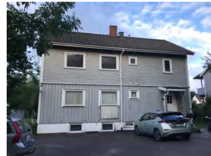
Fasade fra adkomstsiden, øst.
