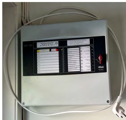
Bilde under viser kablet varsler/detektor i leilighet i 3 etg:
