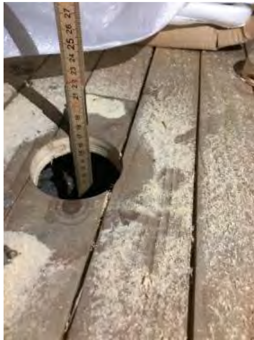
Bilde under viser hull tatt ut i tak/himling i soverom i seksjonen i 2.etasje. Viser porøs plate/trefiberplate montert på ca. 20 mm bord lagt med ukjent senteravstand. Hulrom over tilsier at bjelkelaget er 8 tommer/200 mm.
