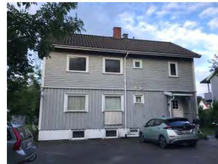
Fasade fra adkomstsiden, øst.
