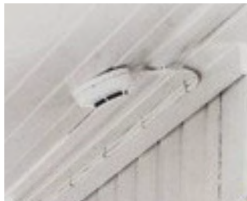
Bilde under viser kablet varsler/detektor i leilighet i 3 etg:
