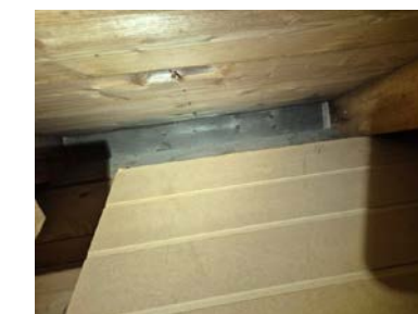
Ingen lufting i nedre del av konstruksjon.
