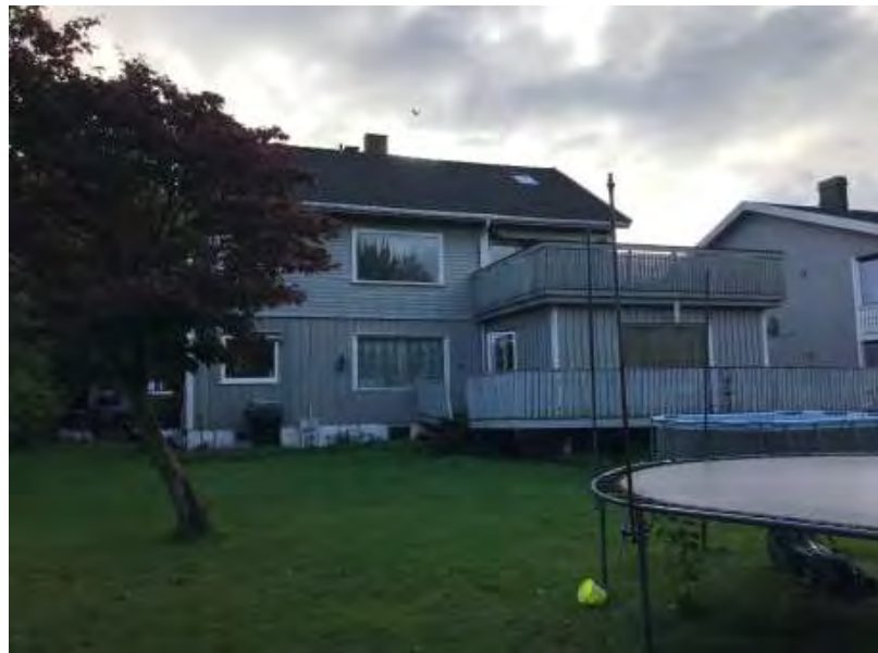
Fasade fra hageside, vest.
