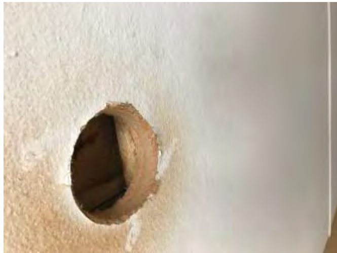
Bilde under viser hull tatt ut i tak/himling i soverom i seksjonen i 2.etasje. Viser porøs plate/trefiberplate montert på ca. 20 mm bord lagt med ukjent senteravstand. Hulrom over tilsier at bjelkelaget er 8 tommer/200 mm.
