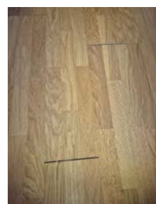
Gliper i gulv på kjøkken i loftetasje.
