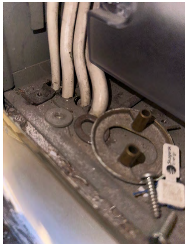
Tredjepartsvurdering av elektriske anlegg, utført av Eiendomstakst1 AS Rapportdato: 17.10.2023
