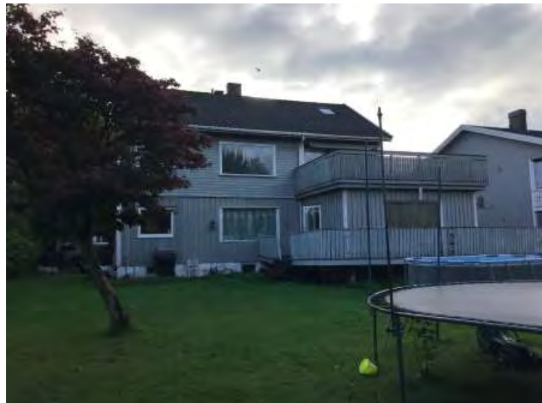
Fasade fra hageside, vest.
