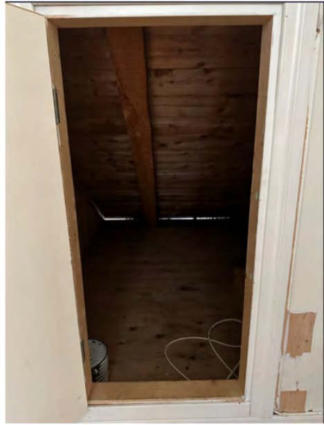
Bilde 3 viser bodareal i loftsetasje, med kun tredekke.
