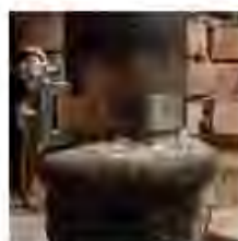
Eks. jording til soilrør (utjevningsforbindelse)
