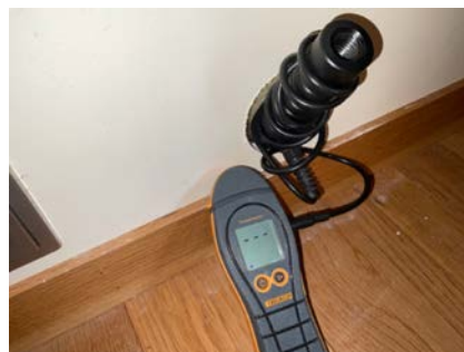
Hull ble tatt på soverom.
