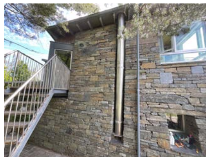
Utvendig pipeløp i stål
