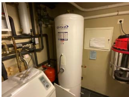
Varmtvannsbereider.
