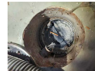
Kontroll av sluk.
