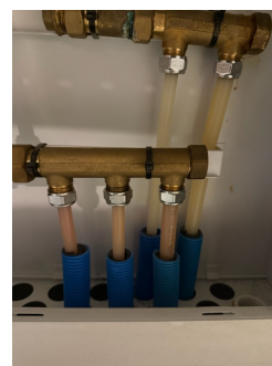
Vannrør i kasse til bad i 2 etasje.
