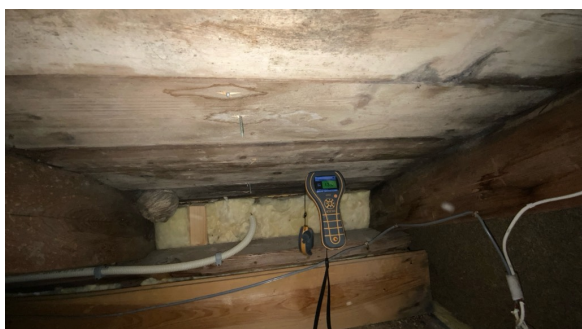
Måling ut mot takutstikk.
