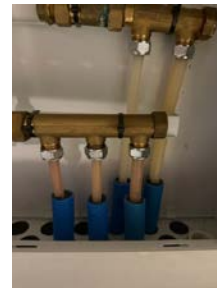
Vannrør i kasse til bad i 2 etasje.
