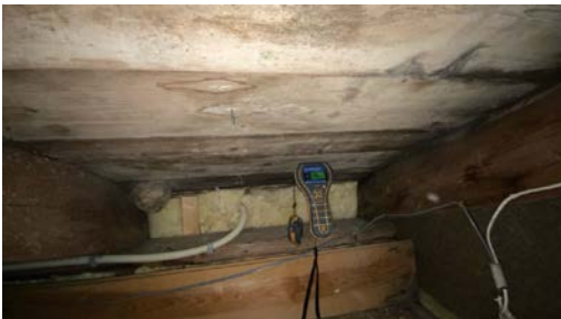
Måling ut mot takutstikk.
