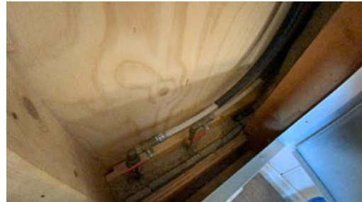
Vannrør i kasse til bad i 2 etasje.
