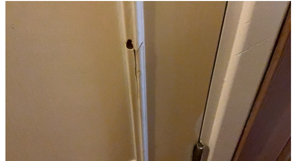
Oppsprekket profilert list på dørbblad
