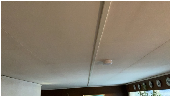
List over plateskjøt i stuetak.
