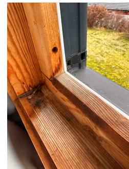
Pakning på kjøkkenvinduet er løs
