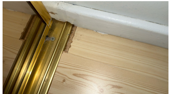
Laminat går ikke under metallisten
