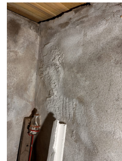
Indikerer fukt på kjellermur ved fuktsøk
