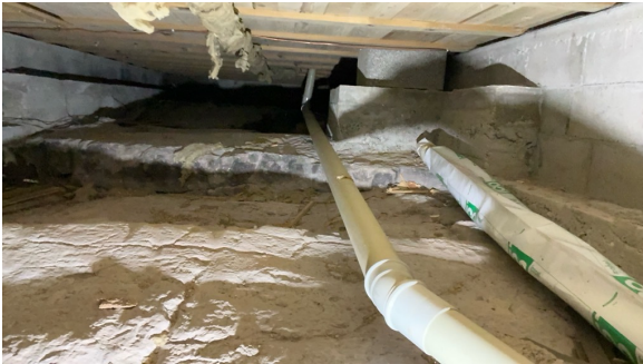
Manglende klamring av avløpsrør
