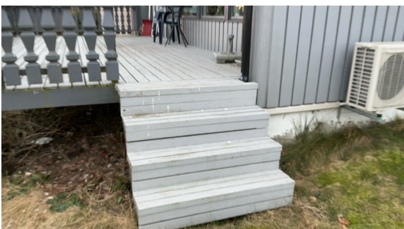
Trapp ved altan til stue
