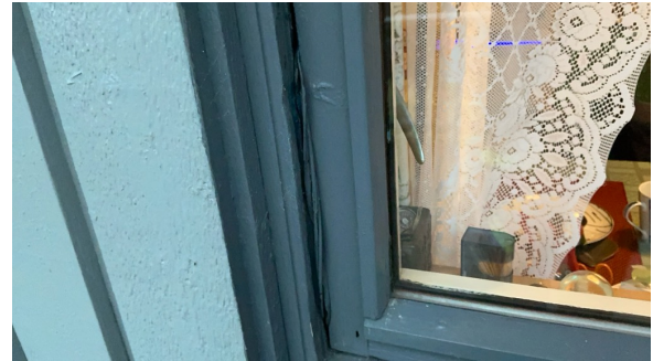
Pakning på kjøkkenvinduet er løs
