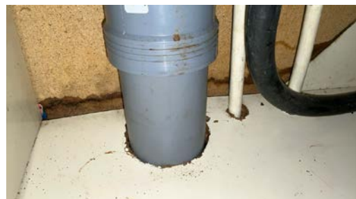
Gammel fuktskade
