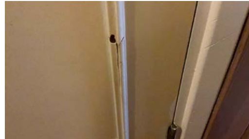
Oppsprekket profilert list på dørbblad
