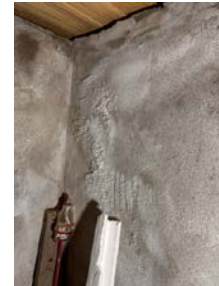
Indikerer fukt på kjellermur ved fuktsøk
