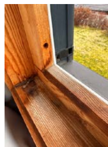
Pakning på kjøkkenvinduet er løs
