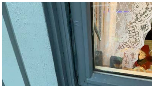
Pakning på kjøkkenvinduet er løs
