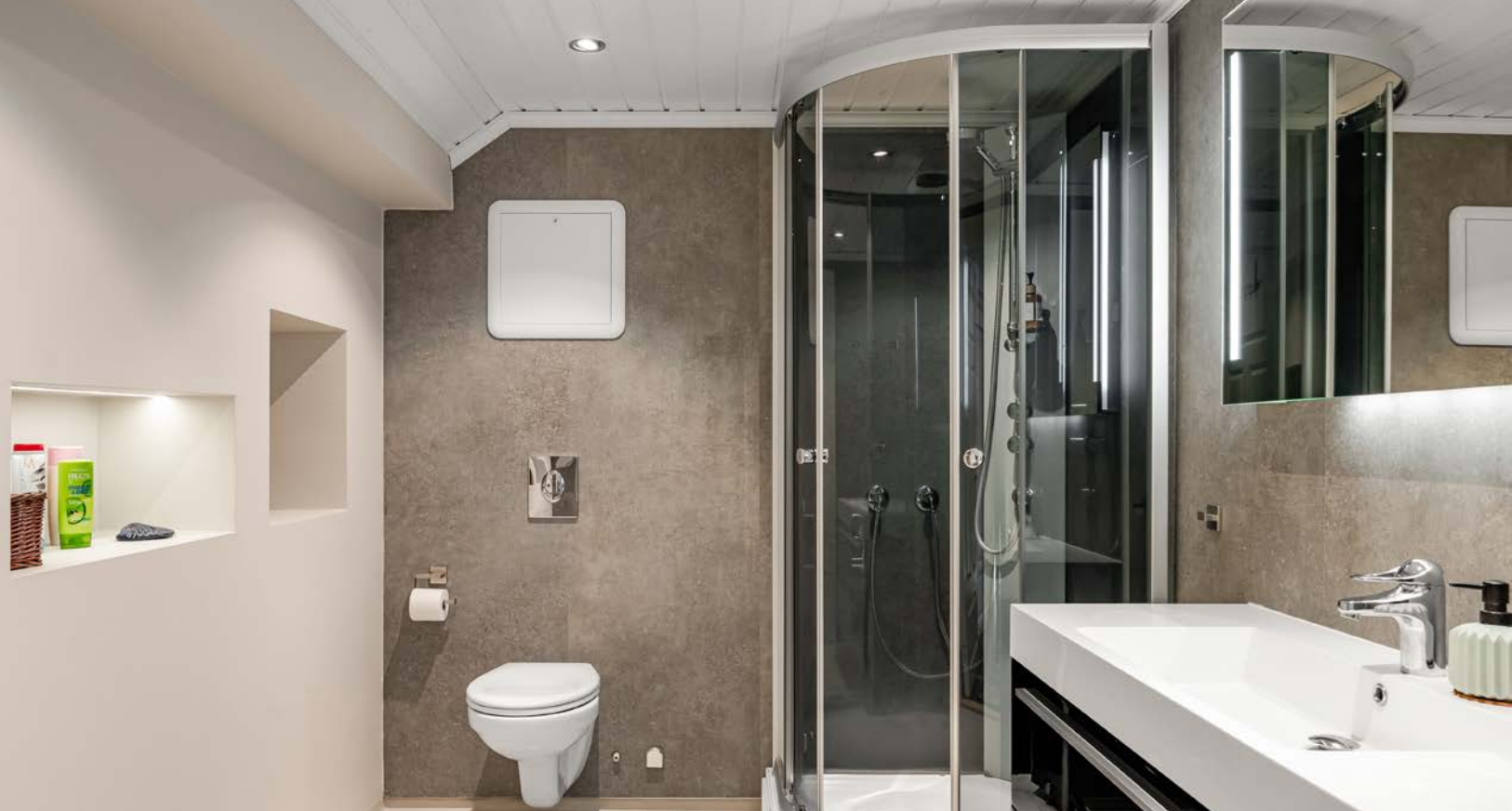
Moderne baderom i 2. etasje med våtromsbelegg på gulv, elektriske varmekabler, overflater med våtromsplater og malte plater, downlights og elektrisk styrt vifte i himlingen.
