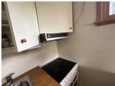
Foto viser mekanisk avtrekk, vifte vurderes å fungere ved test.
