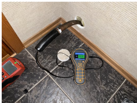
Foto viser fuktmåling i lukket konstruksjon bak badekar. Vurderes tørt på befaringsdagen.
