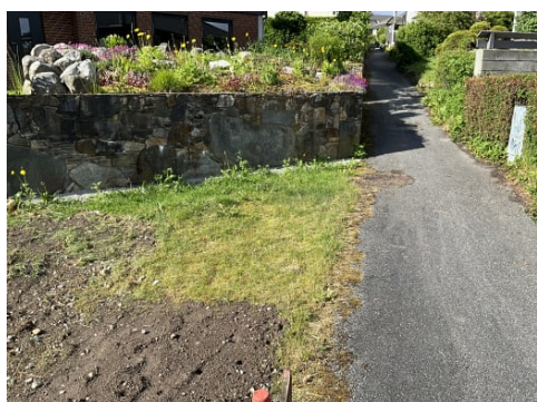
Støttemur mot gangsti/ lekeplass.
