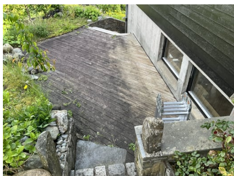
Foto viser treplatting fra byggeår.
