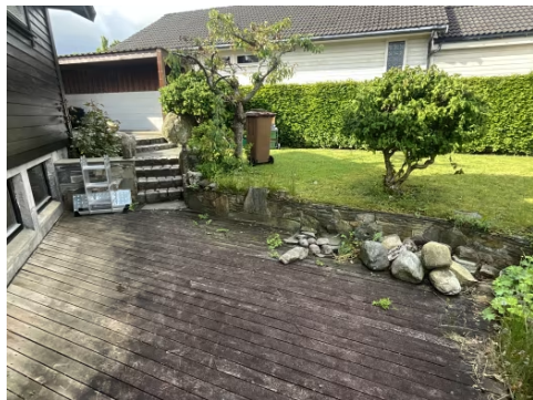
Støttemur mellom nivåer ved platting/ terrasse.
