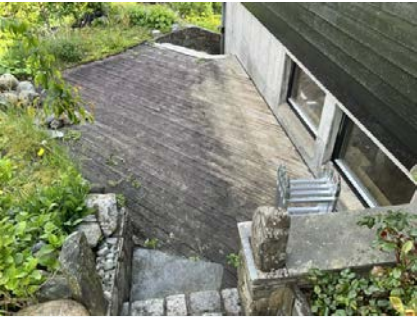
Foto viser treplatting fra byggeår.
