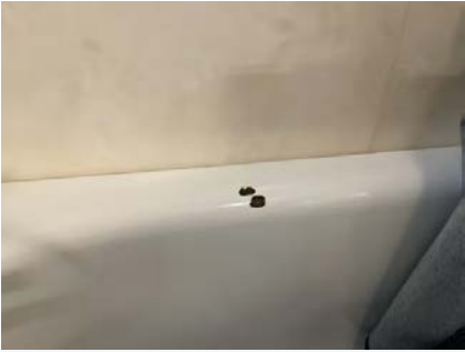
Foto viser mindre skade badekar.
