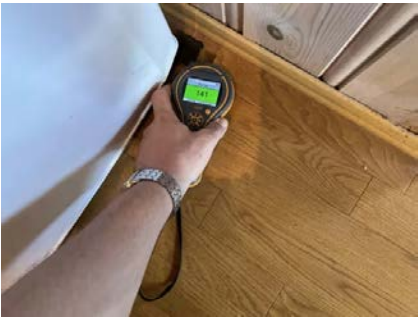
Mindre skader i overflaten parkett, vurderes tørt ut fra referansepunkt i tørrere soner.
