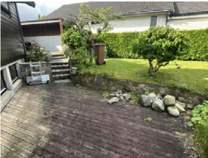
Støttemur mellom nivåer ved platting/ terrasse.
