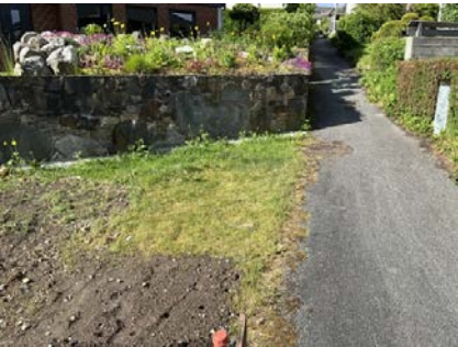
Støttemur mot gangsti/ lekeplass.
