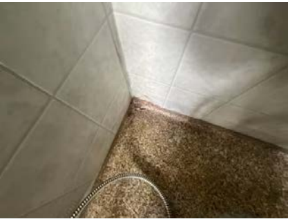
Foto viser utett membran sjikt i dusj på bad.
