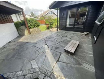
Foto viser platting med skiferheller fra 2006.
