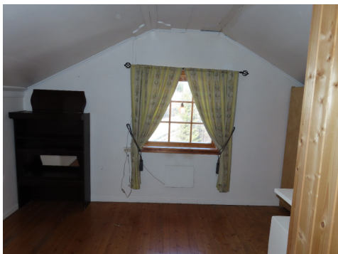
Rømningsvindu på ett av soverommene i 3.etg.
