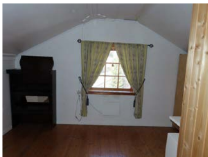
Rømningsvindu på ett av soverommene i 3.etg.
