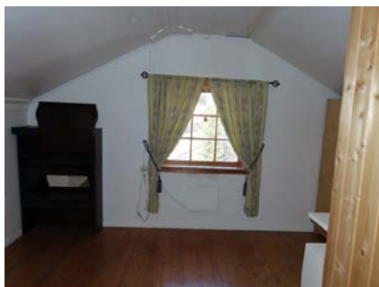
Rømningsvindu på ett av soverommene i 3.etg.
