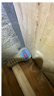
Fukt målt på panel på innforet grunnmur. Synlig plast bak panel.
