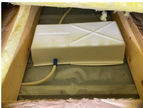
Det er brukt spot-kasser som ikke er dampette.
