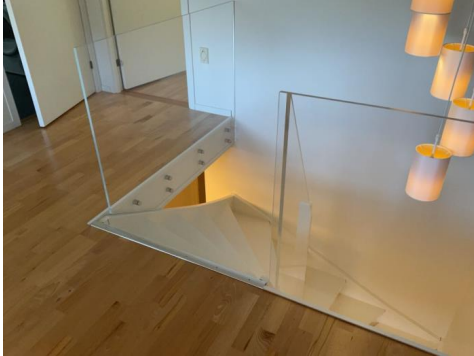
Rekkverk i Plexi-glass.
