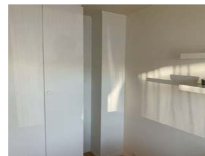
Piper er kledd inn på to sider på soverom i underetasjen.
