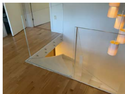
Rekkverk i Plexi-glass.
