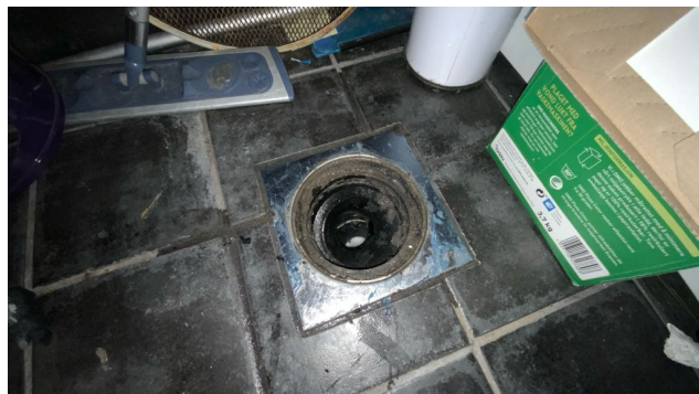
Kontroll av sluk.
