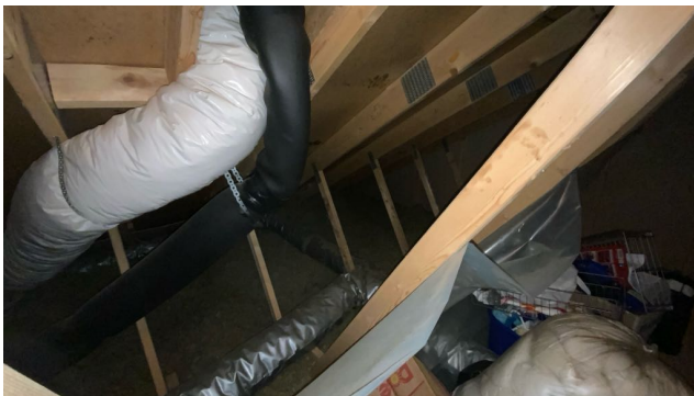
Kontroll rundt rørgjennomføringer.
