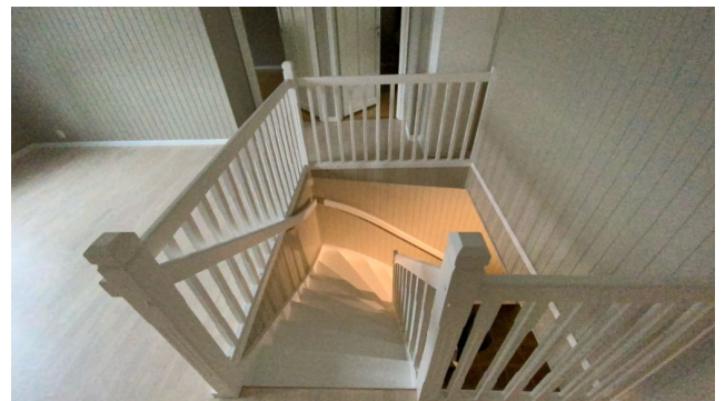
Besiktigelse av trapp.
