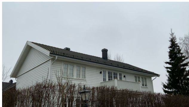
Besiktigelse av taktekke.
