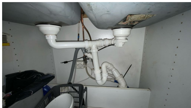
Besiktigelse av røropplegg.
