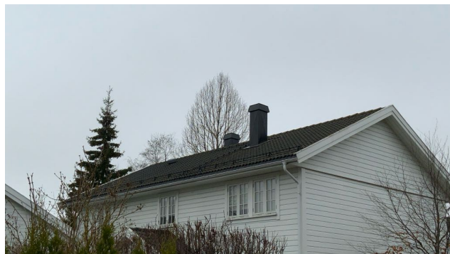
Besiktigelse av taktekke.
