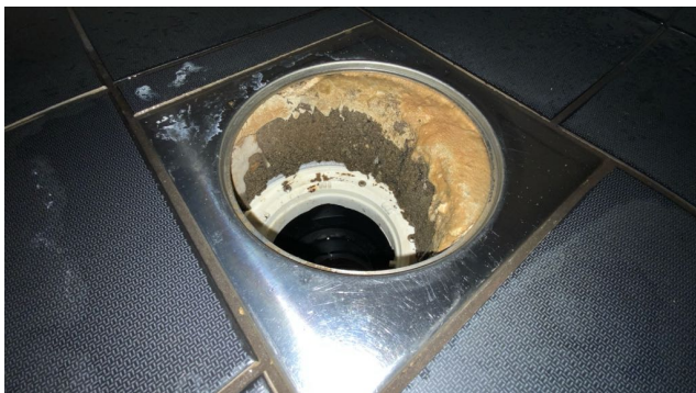
Kontroll av sluk.
