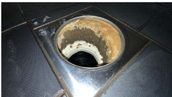
Kontroll av sluk.
