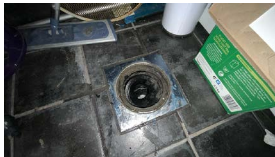
Kontroll av sluk.
