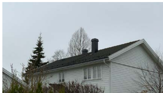
Besiktigelse av taktekke.
