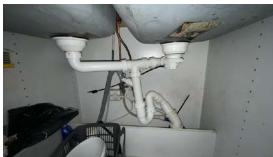
Besiktigelse av røropplegg.
