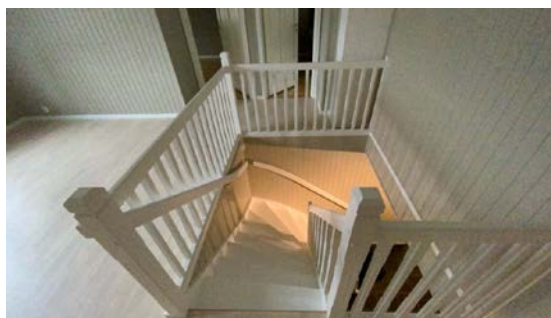
Besiktigelse av trapp.
