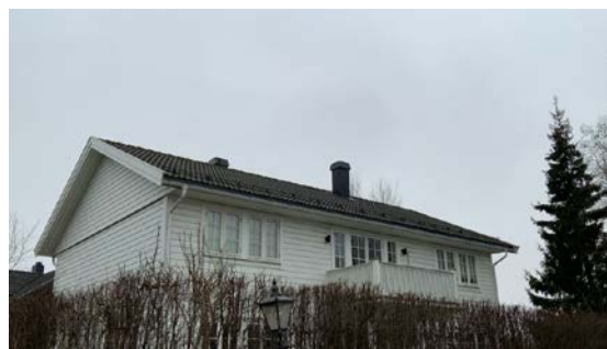
Besiktigelse av taktekke.
