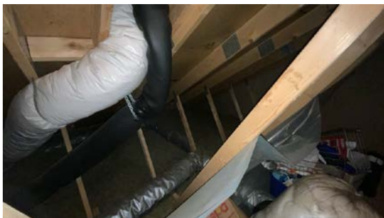
Kontroll rundt rørgjennomføringer.
