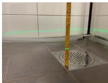
Målt fall til sluk: 21mm.
