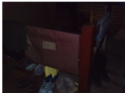
Lav høyde rekkverk på loftet
