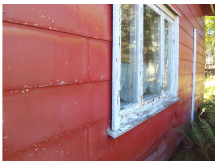
Deler av ene fasaden.
