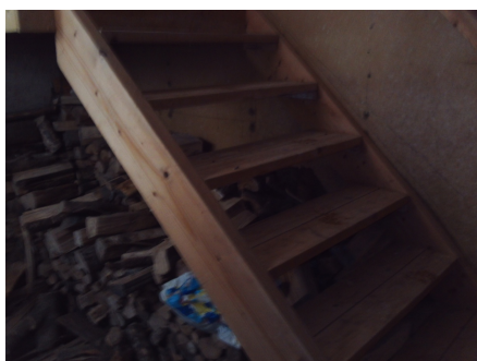
Enkel plassbygget trapp til kjeller
