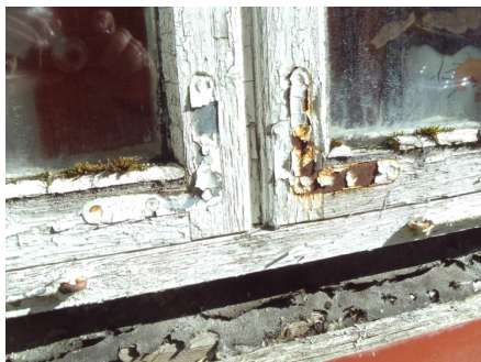
Større skader utvendig og på belistninger
