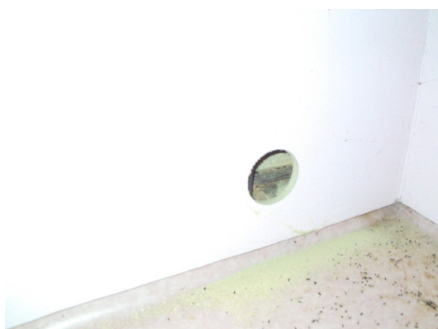
Hulltaking i vegg mot badet.
