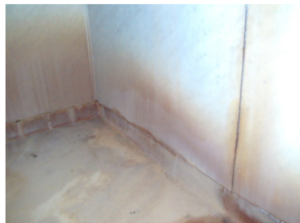
Fuktskadet våtroimsplater i dusjhjørne.
