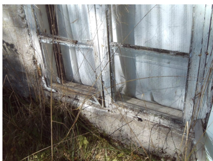
Større skader utvendig og på belistninger
