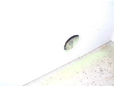
Hulltaking i fra vaskerom i mot badet.
