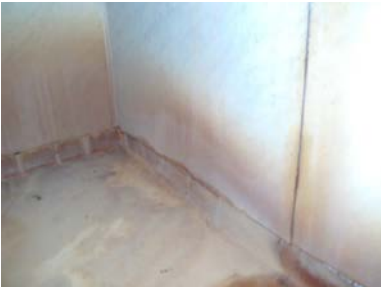
Fuktskadet våtroimsplater i dusjhjørne.
