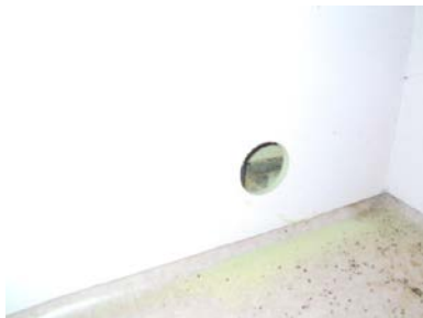
Hulltaking i vegg mot badet.
