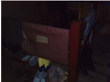
Lav høyde rekkverk på loftet
