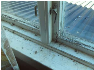
Ene vinduet på loftet.
