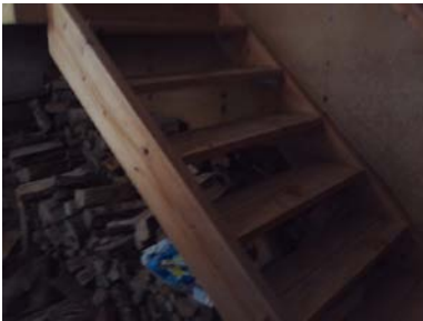
Enkel plassbygget trapp til kjeller
