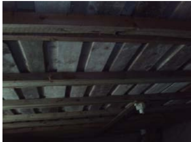
Stubbloft i mot grovkjeller.
