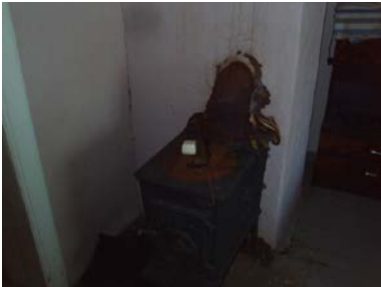
Eldre vedovn med rust.
