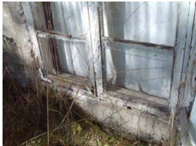
Større skader utvendig og på belistninger
