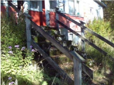
Deler av støpt trapp med rekkverk.
