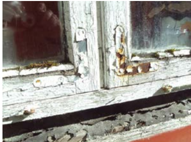
Større skader utvendig og på belistninger
