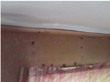
Kondens/fuktskader i trapperommet.
