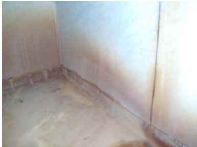
Fuktskadet våtroimsplater i dusjhjørne.
