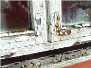
Større skader utvendig og på belistninger
