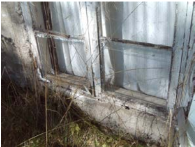
Større skader utvendig og på belistninger
