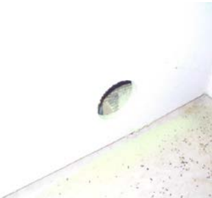
Hulltaking i fra vaskerom i mot badet.
