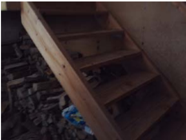
Enkel plassbygget trapp til kjeller
