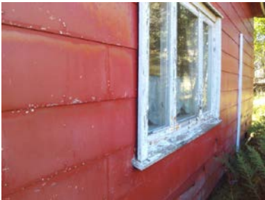
Deler av ene fasaden.
