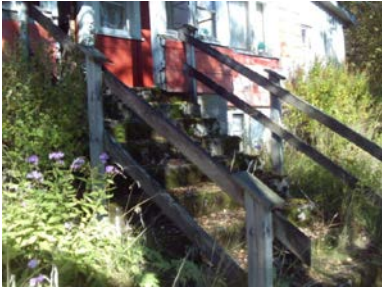
Deler av støpt trapp med rekkverk.
