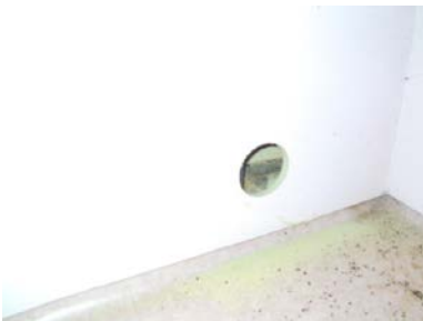
Hulltaking i vegg mot badet.
