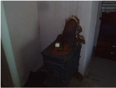
Eldre vedovn med rust.
