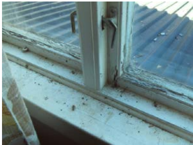
Ene vinduet på loftet.
