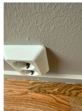
Bildet viser stikkontakt med sprekk i dekslet.
