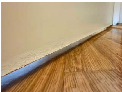
Bildet viser svelling på dørbblad.
