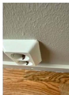
Bildet viser stikkontakt med sprekk i dekslet.
