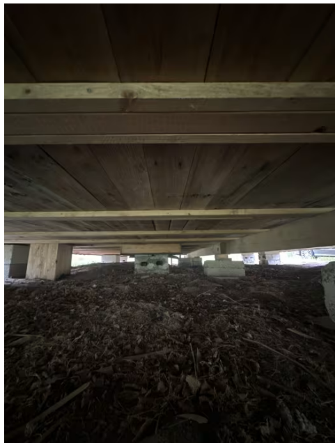
Viser kryperom under hytta
