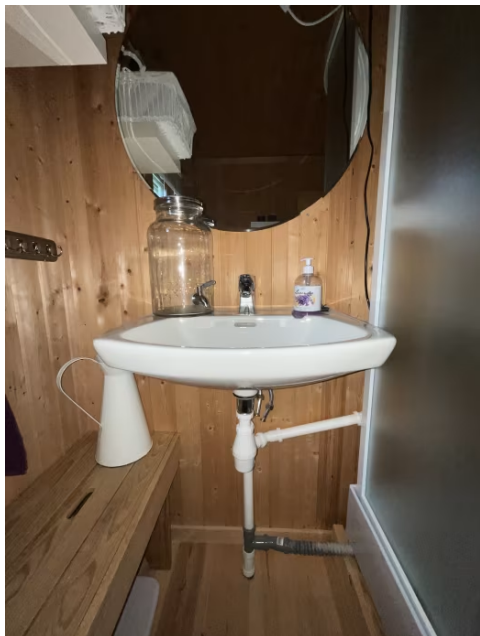
Viser vask og avløpsinstallasjoner ført til grunnen.
