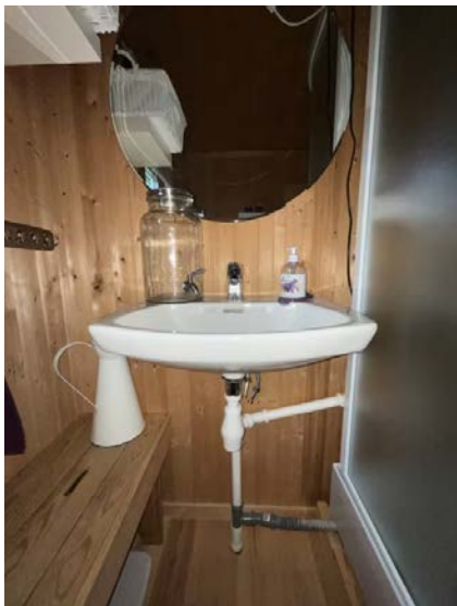
Viser vask og avløpsinstallasjoner ført til grunnen.
