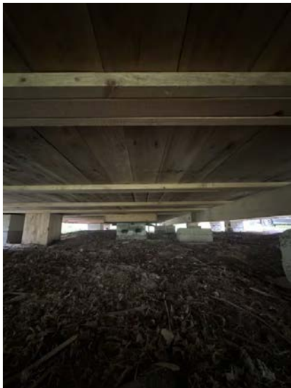
Viser kryperom under hytta
