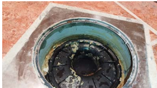
Kontroll av sluk.
