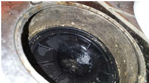
Kontroll av sluk.
