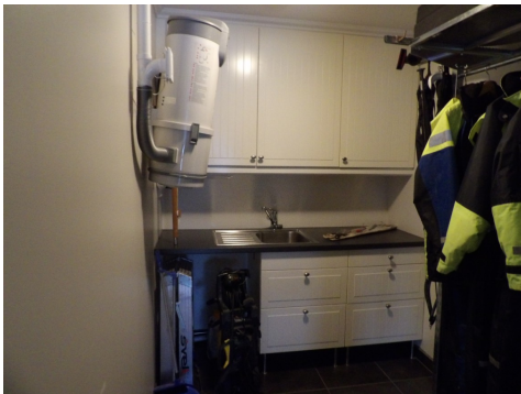
Montert skap, benkeplater og utslagsvask i bod.
