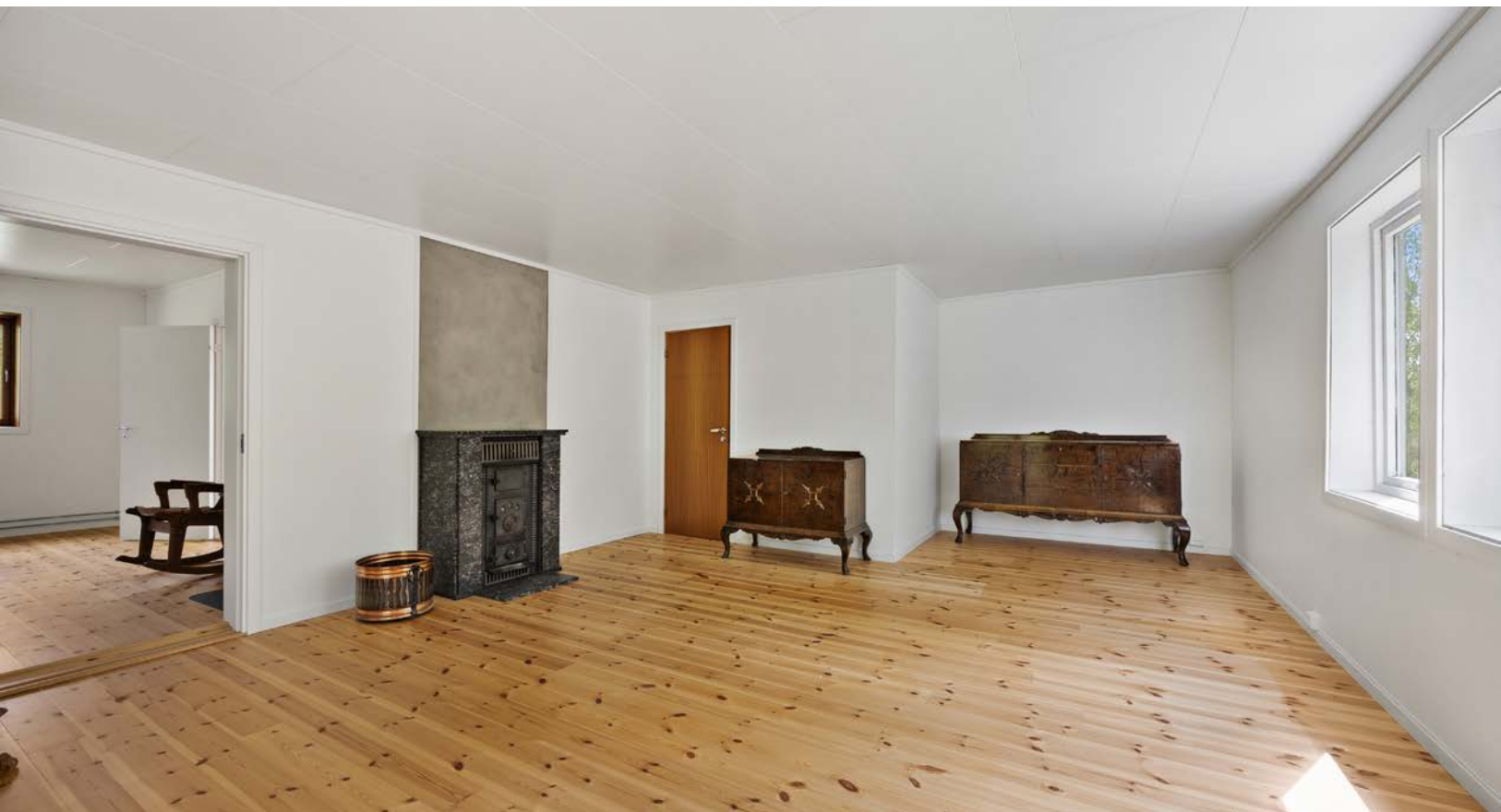
Boligen har flere ildsteder - blant annet vedkamin, vanlig vedovn og hvit vedkomfyr. Det gjøres oppmerksom på synlige sprekker i pipen, så fyring bør avvantes.
