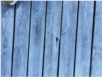
Råteskader spaltegulv
