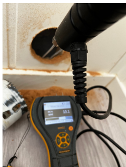
Hulltaking/ fuktmåling utforet vegg
