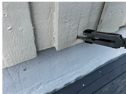
Råteskadet kledning
