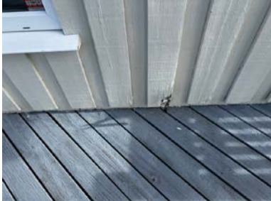
Råteskadet kledning
