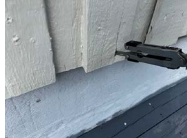
Råteskadet kledning
