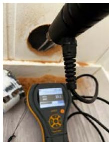
Hulltaking/ fuktmåling utforet vegg
