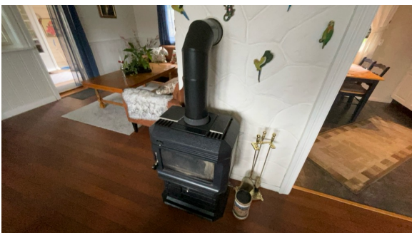
Montert ovn i stue.
