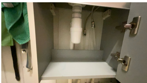
Del av rør til avløp.
