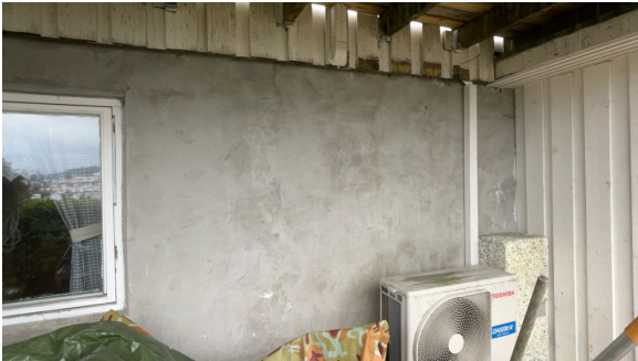
Del av grunnmur.
