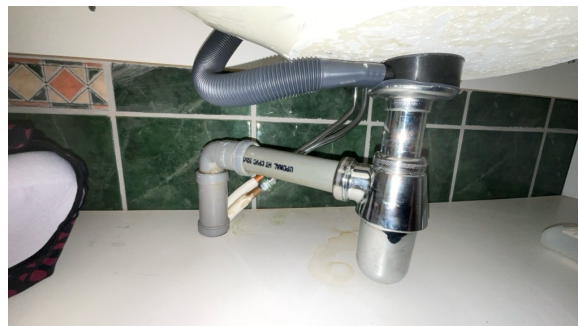
Del av rør til avløp.
