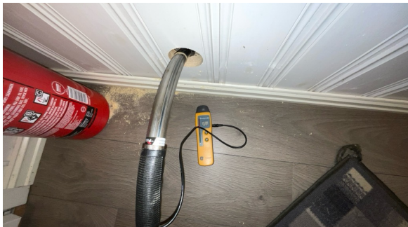
Hull for kontroll av fukt.
