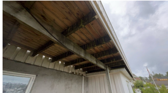
Del av terrasse sett fra undersiden.
