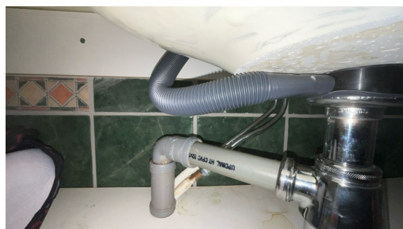
Del av rør til vann.
