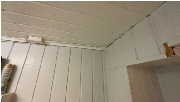
Del av vegg - tak.
