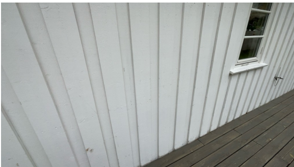
Del av vegg.
