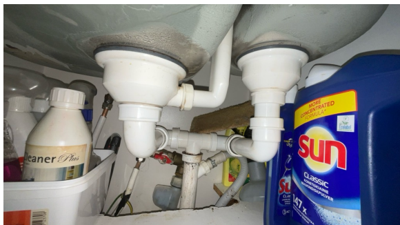
Del av rør til avløp.
