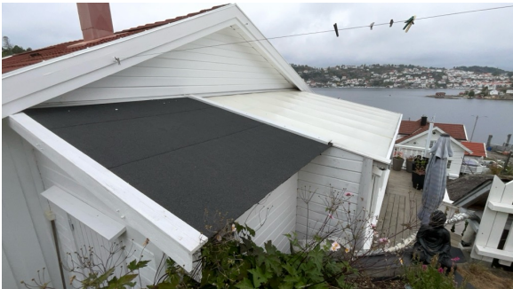
Del av taktekking.
