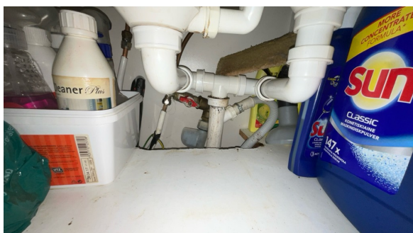
Del av rør til vann.
