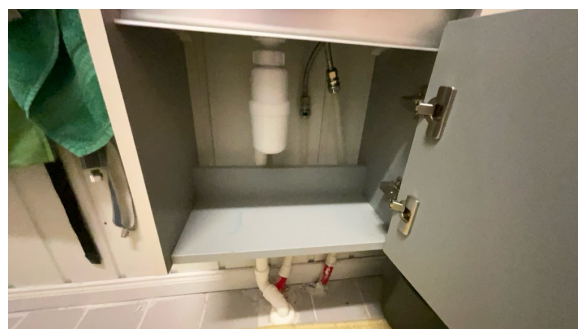
Del av rør til vann.
