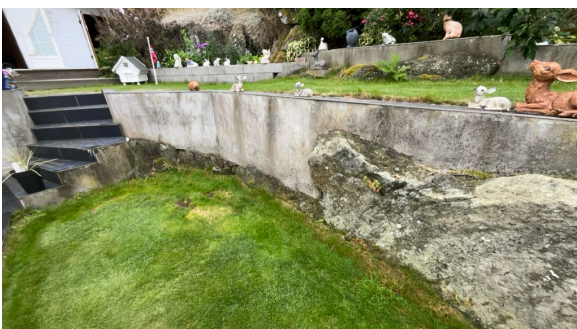
Del av forstøtningsmur.
