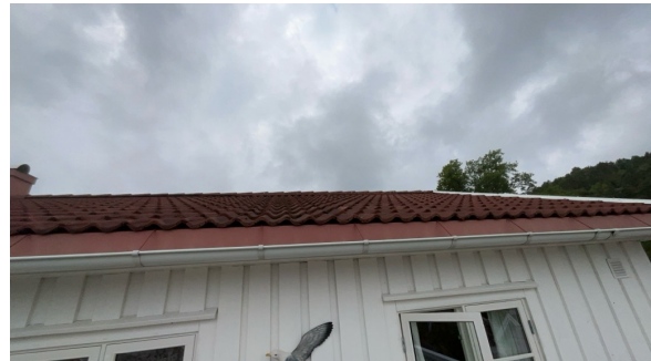
Del av taktekking.
