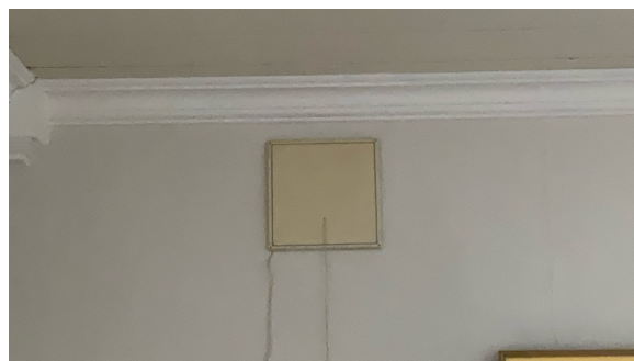
Eksempel på montert ventil i vegg.
