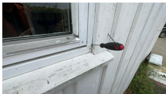
Stikk kontroll på vinduer er utført.
