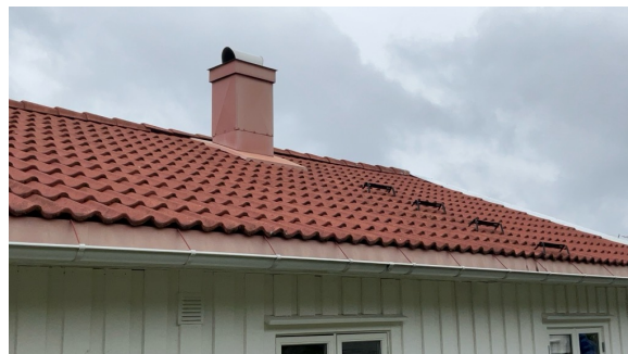
Del av rennesystem. Pipebeslag.
