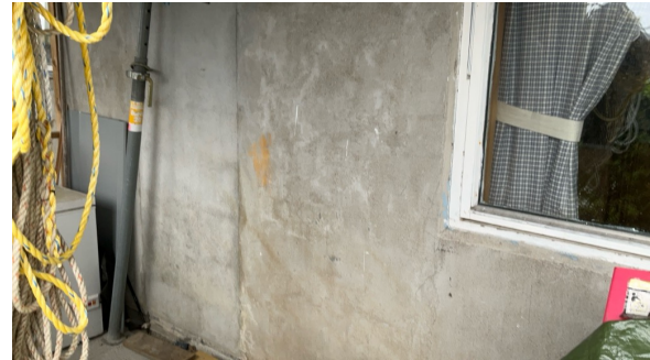
Del av grunnmur.
