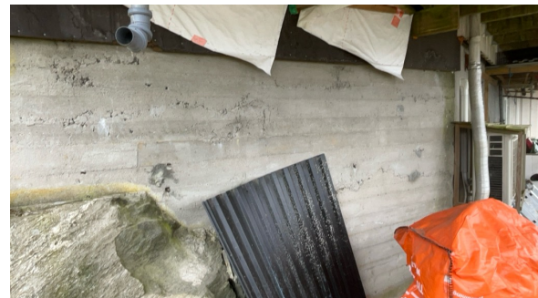
Del av forstøtningsmur.
