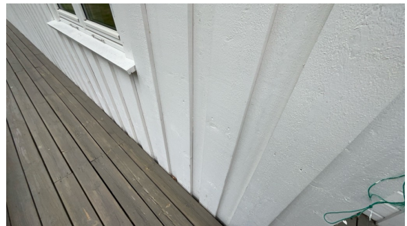
Del av vegg.
