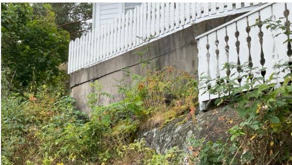
Del av forstøtningsmur.
