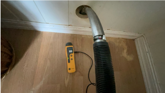
Hull for kontroll av fukt.
