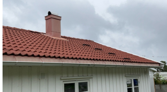
Del av taktekking.
