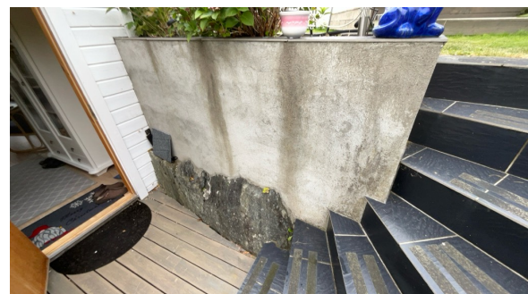
Del av forstøtningsmur.
