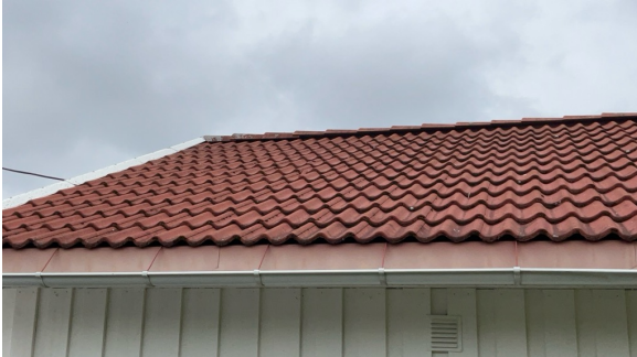
Del av taktekking.
