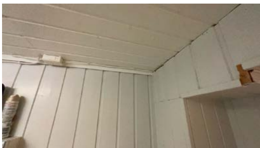
Del av vegg - tak.
