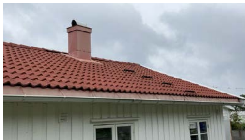
Del av taktekking.
