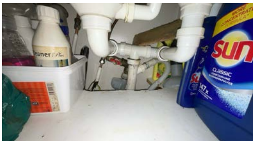
Del av rør til vann.
