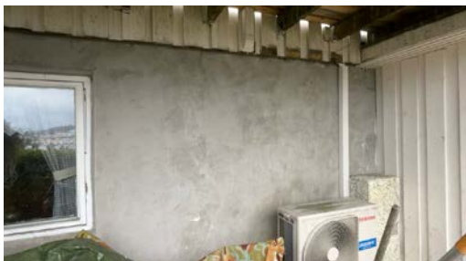
Del av grunnmur.
