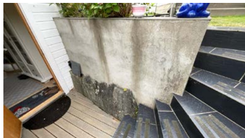
Del av forstøtningsmur.
