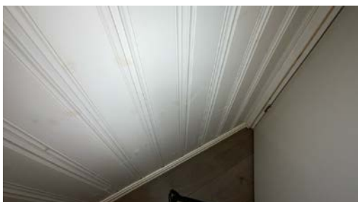
Del av rom under terreng.
