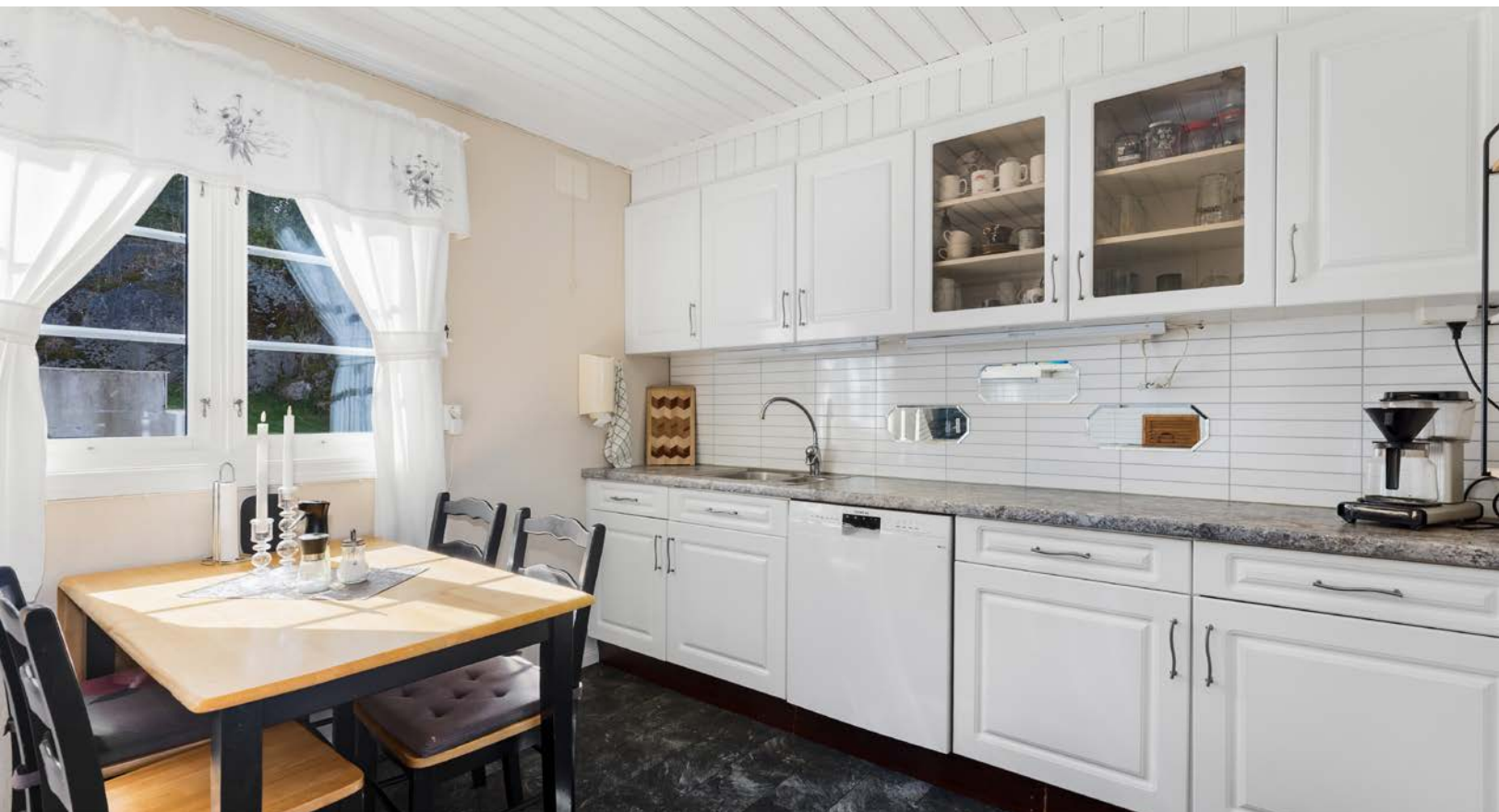
Det er montert kjøkkenplater mellom over- og underskap.
