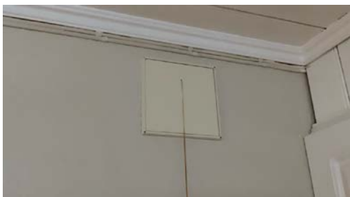
Eksempel på montert ventil i vegg.
