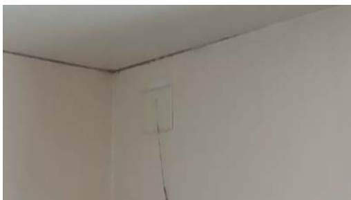
Eksempel på montert ventil i vegg.
