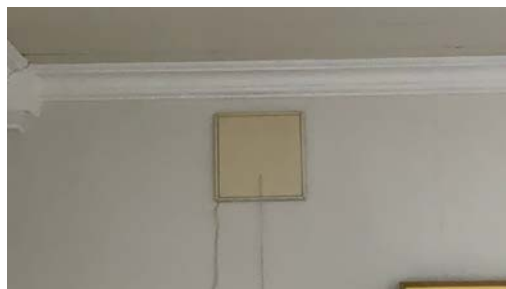
Eksempel på montert ventil i vegg.
