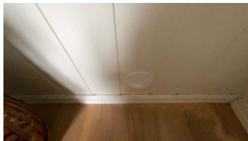
Lokk over hull.
