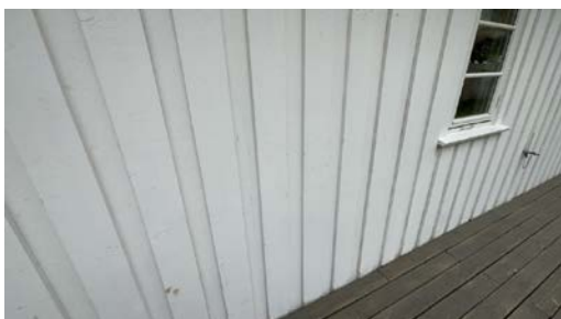
Del av vegg.
