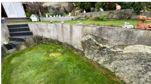
Del av forstøtningsmur.
