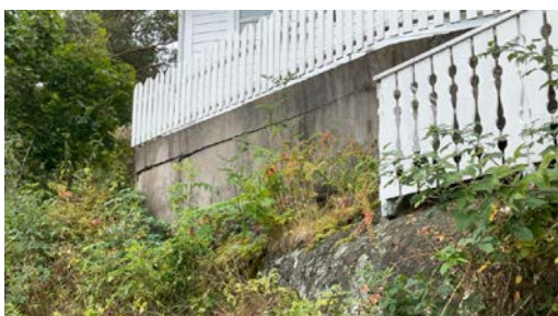
Del av forstøtningsmur.
