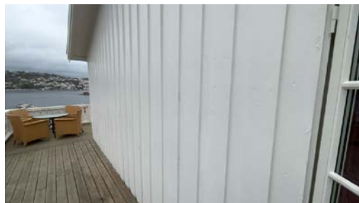
Del av vegg.
