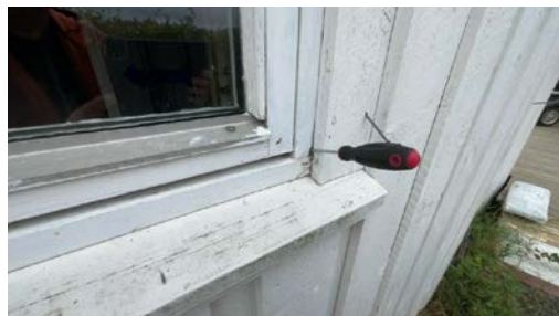
Stikk kontroll på vinduer er utført.
