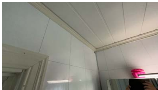
Del av vegg - tak.
