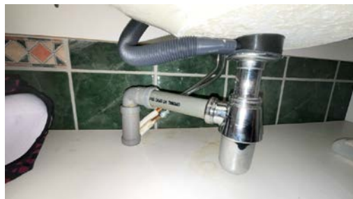
Del av rør til avløp.
