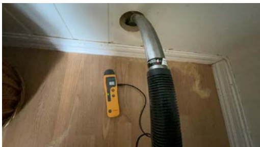
Hull for kontroll av fukt.
