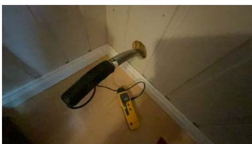
Hull for kontroll av fukt.
