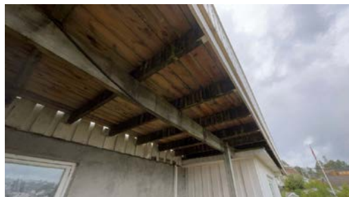
Del av terrasse sett fra undersiden.
