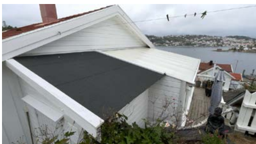
Del av taktekking.
