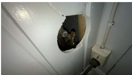
Stoppekran til vann.
