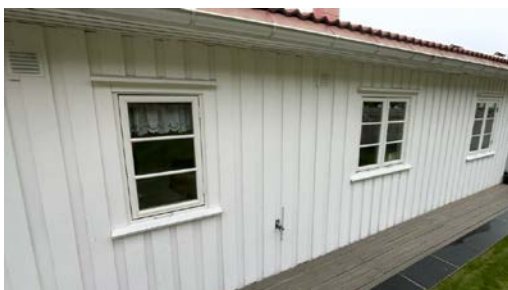
Eksempel på vindu i yttervegg.
