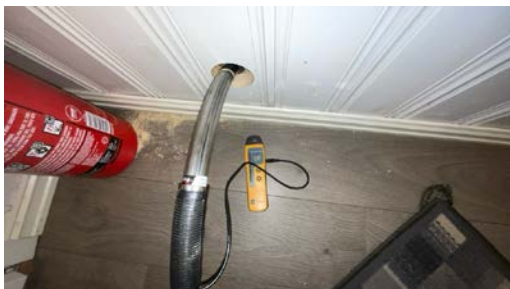
Hull for kontroll av fukt.
