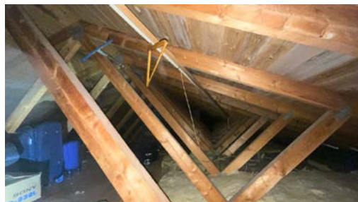
Del av takkonstruksjon, sett fra loft.
