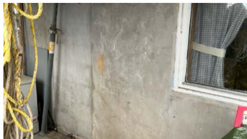
Del av grunnmur.
