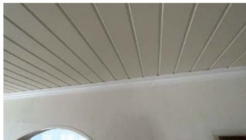
Del av vegg - tak.
