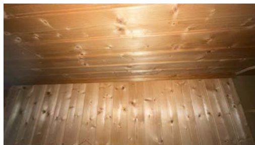
Del av vegg - tak.
