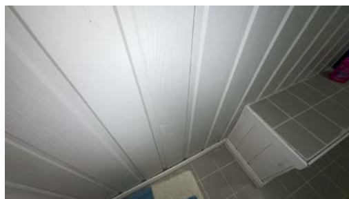
Del av rom under terreng.
