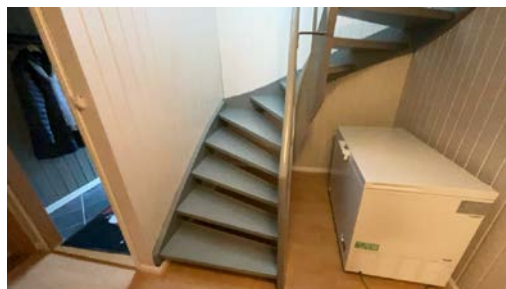
Trapp opp til 1 etasje.
