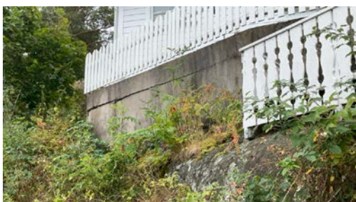
Del av forstøtningsmur.
