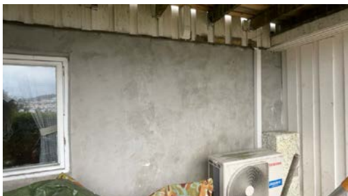
Del av grunnmur.
