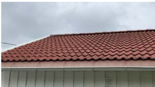
Del av taktekking.
