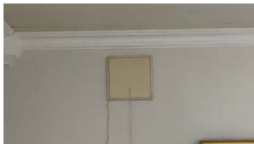
Eksempel på montert ventil i vegg.
