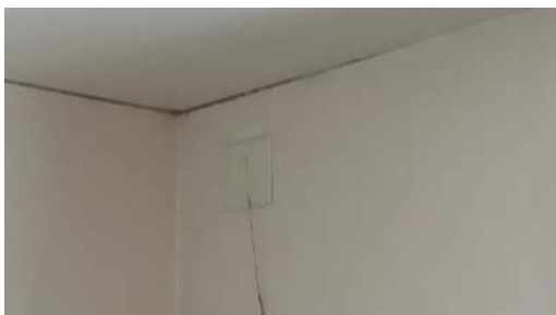
Eksempel på montert ventil i vegg.
