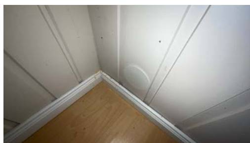
Lokk over hull.
