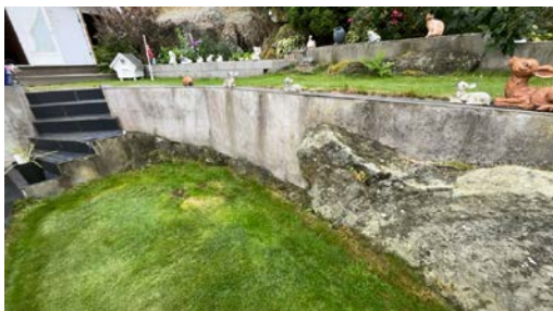
Del av forstøtningsmur.
