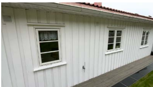
Eksempel på vindu i yttervegg.
