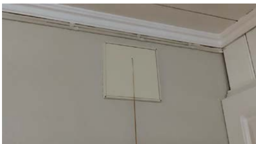
Eksempel på montert ventil i vegg.
