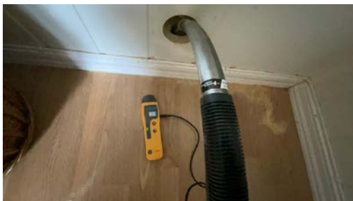
Hull for kontroll av fukt.
