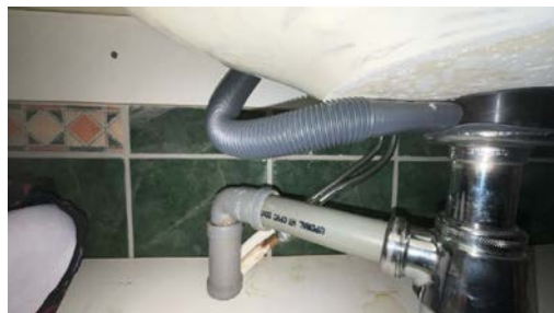
Del av rør til vann.
