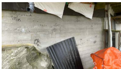
Del av forstøtningsmur.
