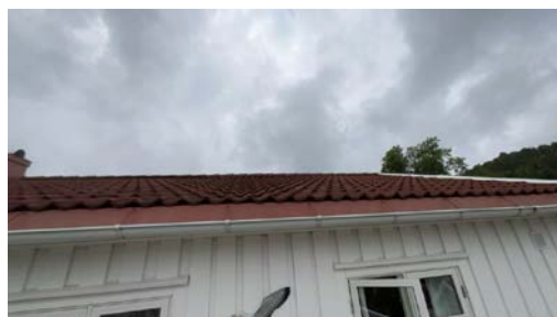
Del av taktekking.
