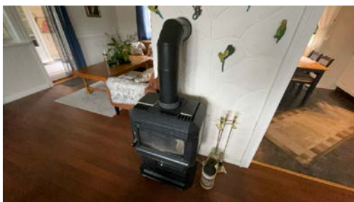
Montert ovn i stue.
