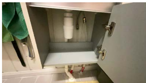
Del av rør til vann.
