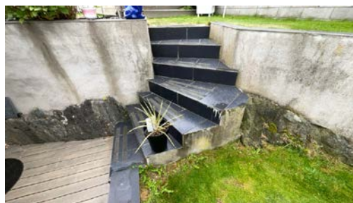
Trapp mellom terreng.
