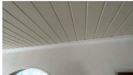
Del av vegg - tak.
