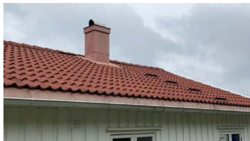
Del av rennesystem. Pipebeslag.
